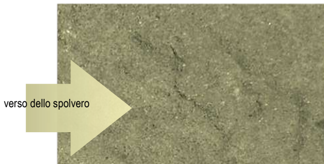
effetto "onda" per errato spolvero
